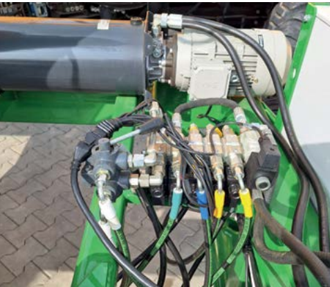
Hydraulický stroj s hydraulickým rozdělovačem
