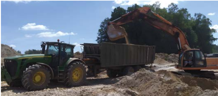
Lavori di costruzione
